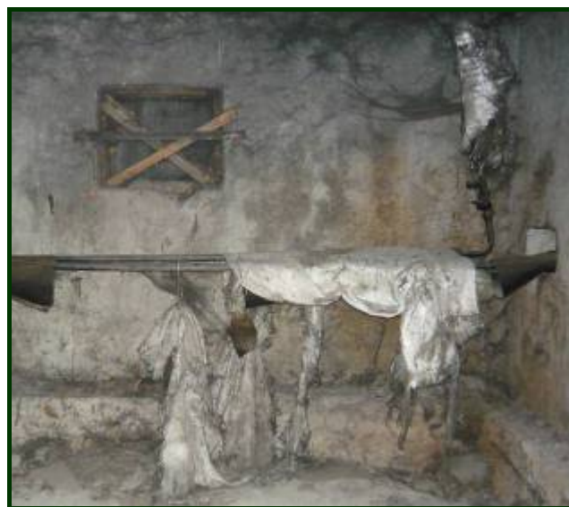
Участки с нарушенной теплоизоляцией
